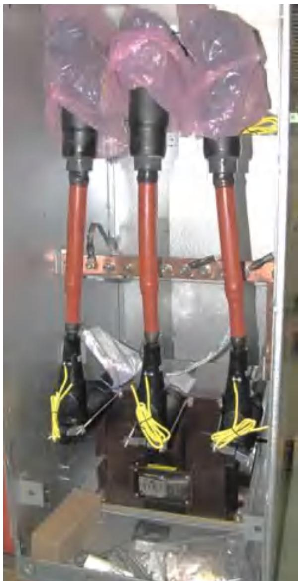
Внешний вид трансформаторов напряжения
