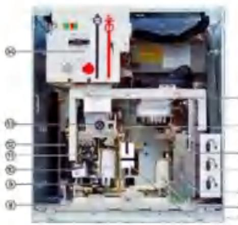
Рисунок 1 - Привод силового выключателя
