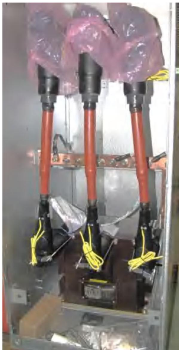
Внешний вид трансформаторов напряжения
